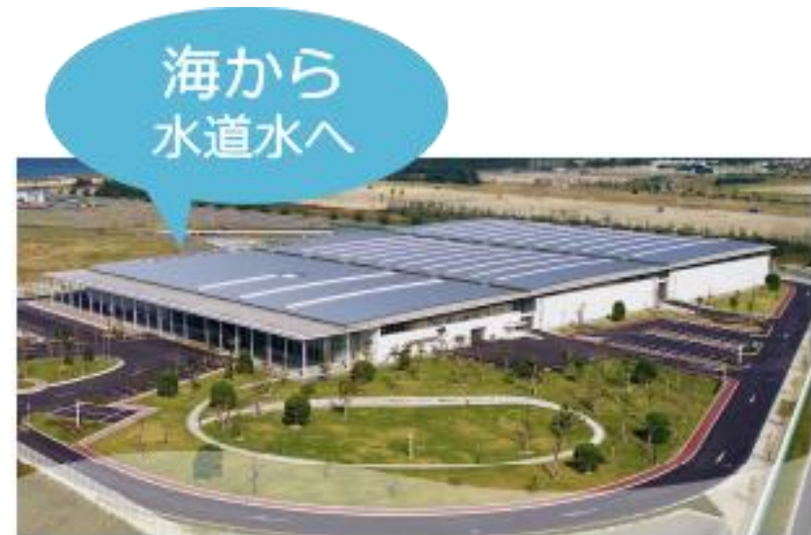
海水淡水化センター（まみずピア）外観写真 ※HPより抜粋
